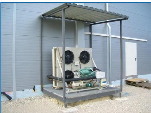
Munz Kältemaschine mit halbhermetischem Verdichter und
