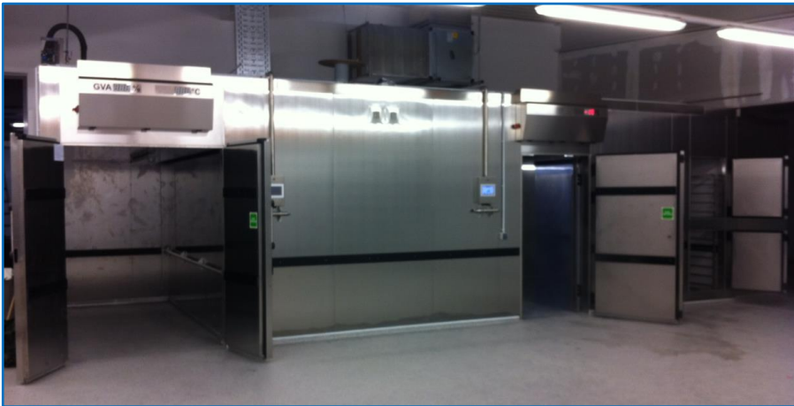
links: Front Gärraum mit Schaltschrank und Munz Greenline GL Steuerung
