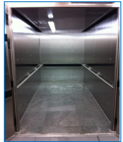
rechts: Blick in den Gärraum für 6 Stikken mit Luftleitdecke und Rammschutz zur Luftführung
